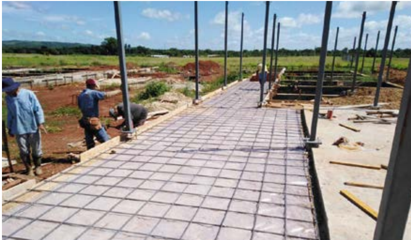
Das Fundament für das neue Kloster ist fast fertig, die Fertigteile sind unterwegs zur Baustelle und werden demnächst aufgestellt
